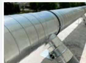
Afin de s'adapter parfaitement à l'envergure de votre stockage à plat et à votre bâtiment, nos gaines spiralées sont également fabriquées dans notre usine, sur mesure, elles assurent la jonction entre le ventilateur et les caniveaux de ventilation / séchage.
